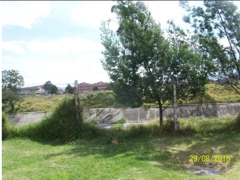
Foto 2. Sitio del Box Coulvert existente sobre el Canal del río Fucha con Carrera 71D (Centro Comercial El Edén). Fuente: SDA, 2016.
