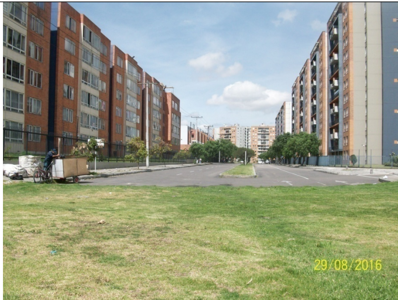
Foto 3. Vía que va a conectar el Box Coulvert existente sobre el Canal del río Fucha con Carrera 71D (Centro Comercial El Edén). Fuente: SDA, 2016.
